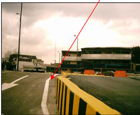
Ilustración 14 Irregularidades en las curvas del separador y las demarcaciones - conectante
