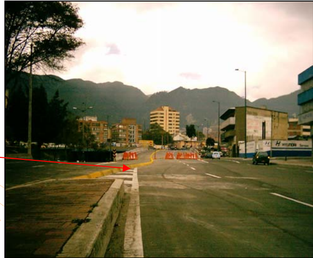
Ilustración 10 Demarcación incorrecta de curvatura de acceso a conectante
