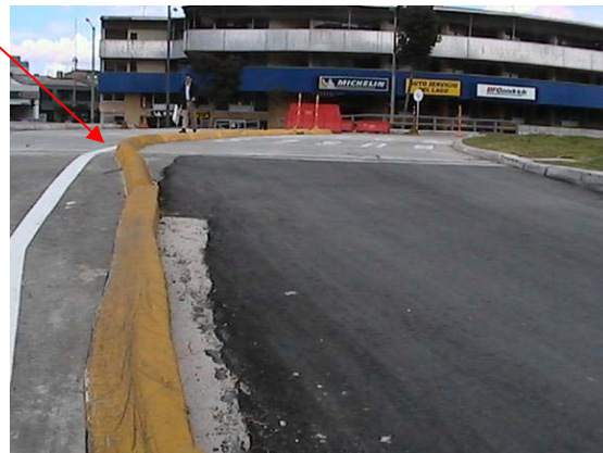
Ilustración 14 Irregularidades en las curvas del separador y las demarcaciones - conectante
