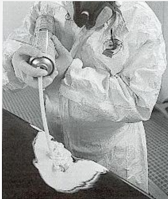
Reparación con Resinas
