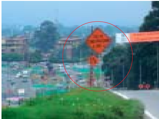
Señalización vertical excesiva y canalización inadecuada (proyecto en construcción).
