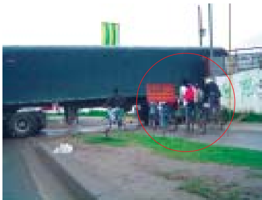
Problemas de acceso a predios adyacentes.
