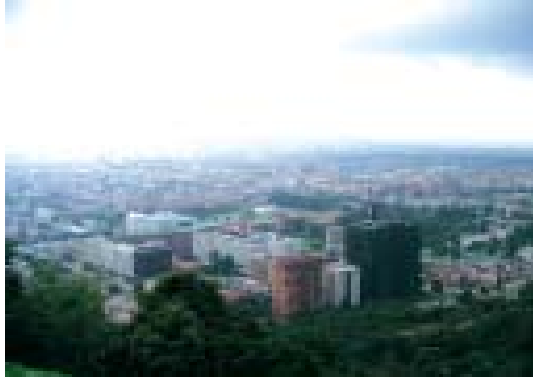
Topografía del entorno.
