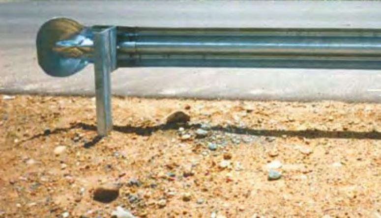
Las defensas son reflectivas, recuperables, de instalación sencilla, rápida, económica y requieren gastos mínimos de conservación. Reducen la gravedad de los accidentes, corren la dirección de avance de los vehículos e impiden que aquellos fuera de control se salgan de la calzada.
