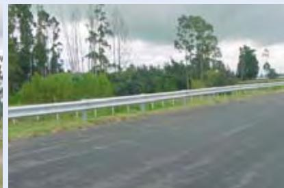
Las Defensas viales flexibles Flex-Beam doble onda en forma de "W", son vigas fabricadas de acuerdo con las normas Americanas AASHTO y Europeas EN con longitudes efectivas de 3.81 y 4.00 mts respectivamente, que se fijan a separadores y/o postes por medio de pernos. Todos los elementos son fabricados en acero y galvanizados en caliente a excepción de los espaciadores, los cuales se fabrican igualmente en polietileno de alta densidad.
